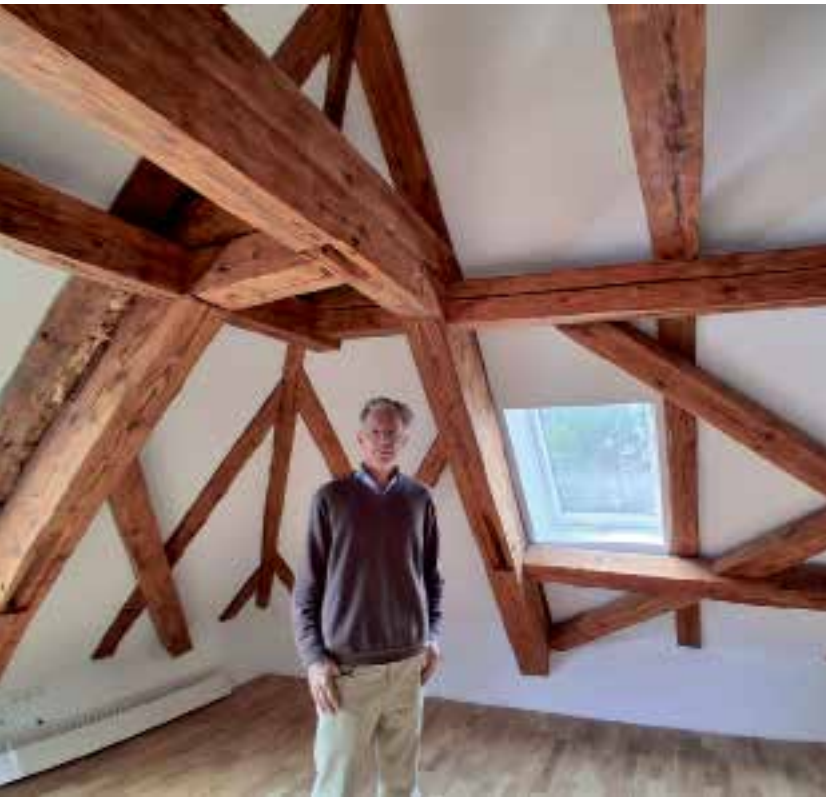
Der Hausherr präsentiert den historischen Dachstuhl; Foto: Ilse Weber
