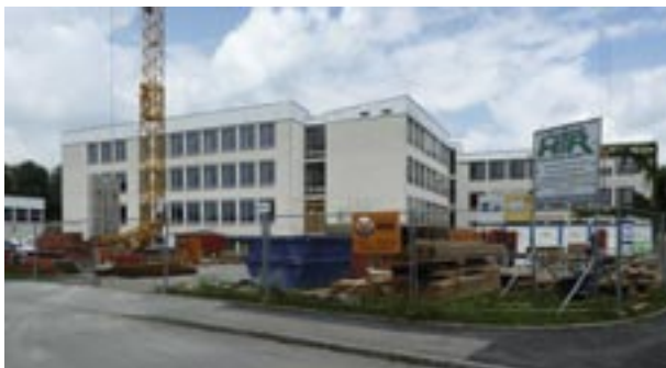
Aus- und Umbau der RS Herrsching ; Foto vom 02.07.2011
