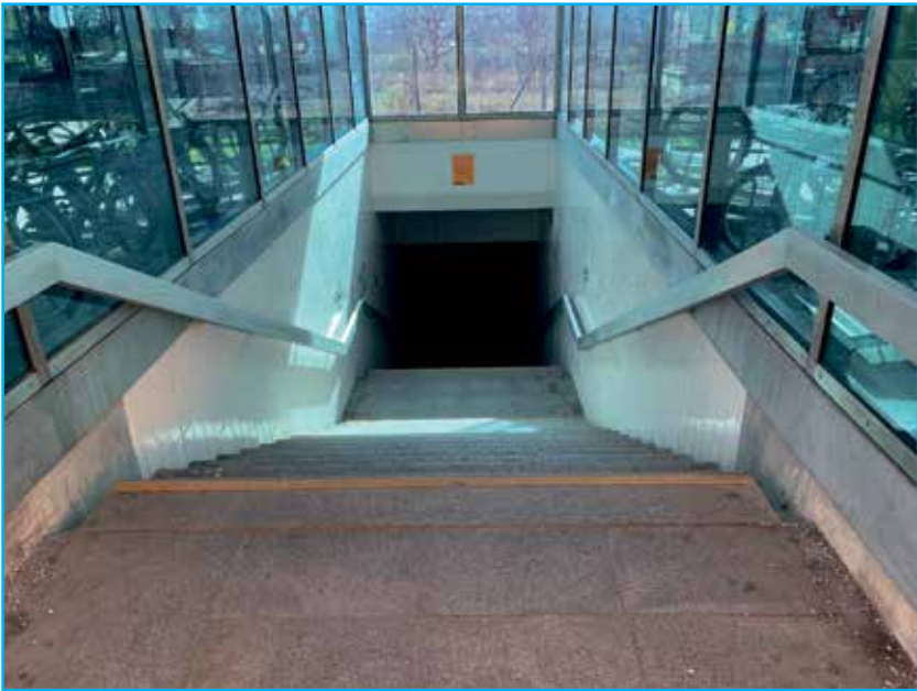
Die leidige Treppe am Hechendorfer Bahnhof - immer wieder ein unüberwindbares Hindernis; Foto: Ute Dorschner
