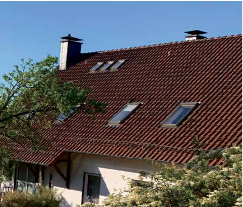
Bald haben nur noch alte Häuser große, aktive Schornsteine auf dem Dach. Foto: Ute Dorschner
