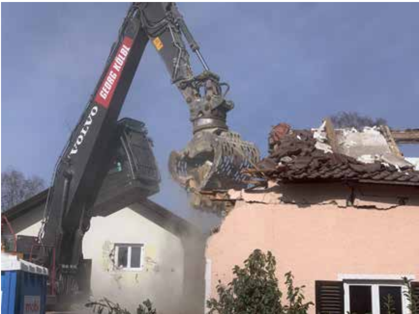
Zwei Abbruchhäuser im März 2023, Foto: Ute Dorschner
