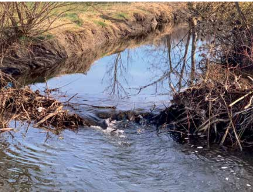
Mit Dränagerohren hätte der Biberdamm an der alten Kläranlage nicht zerstört werden müssen.
