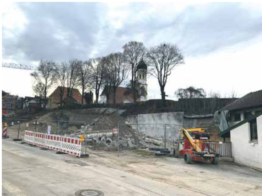
Stampfgasse im Dezember 2021: Die bestehenden Gebäude waren baufällig und wurden abgerissen. Foto: Ute Dorschner
